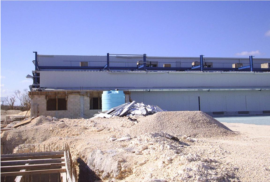
Figura No. 1.4 Desprendimiento de la lámina de los muros.
