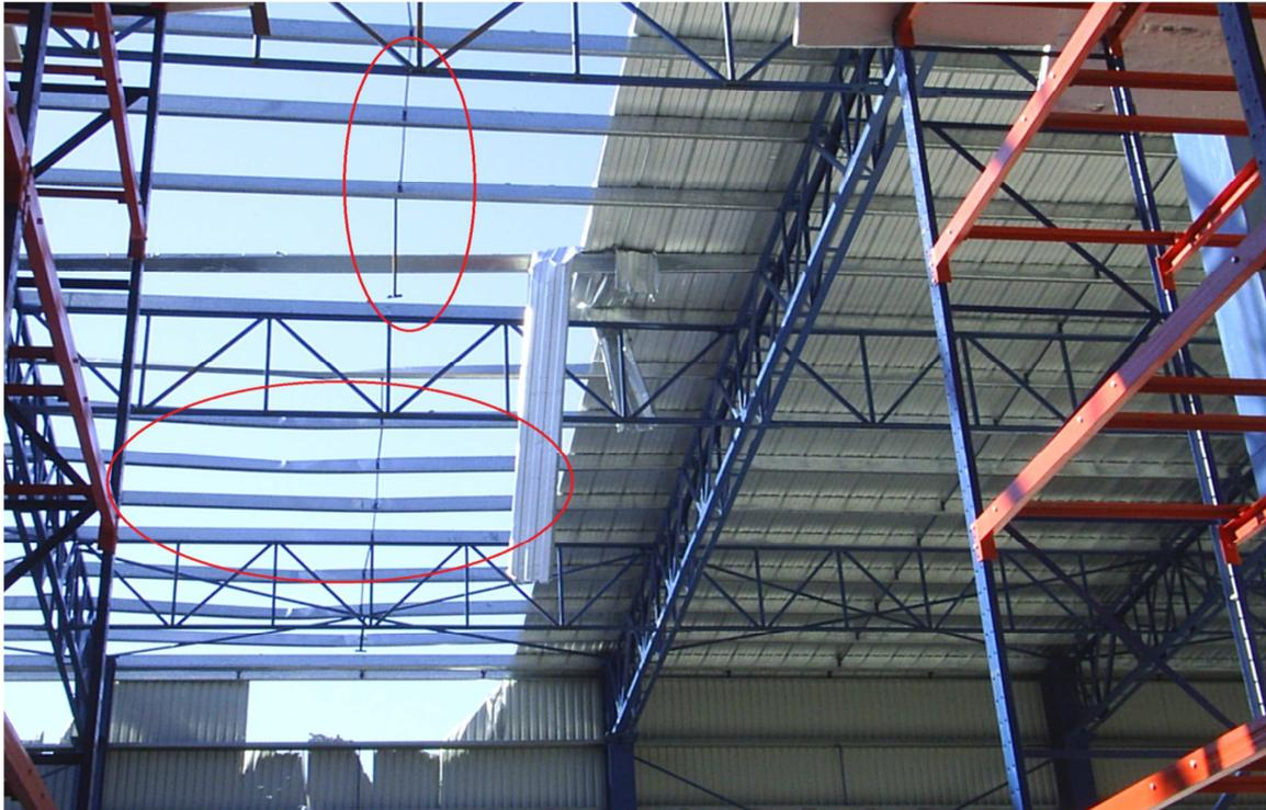
Figura No. 1.11 Deformación de los largueros de la cubierta.
