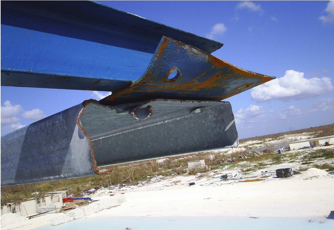
Figura No. 1.16 Conexión dañada de los largueros del muro.
