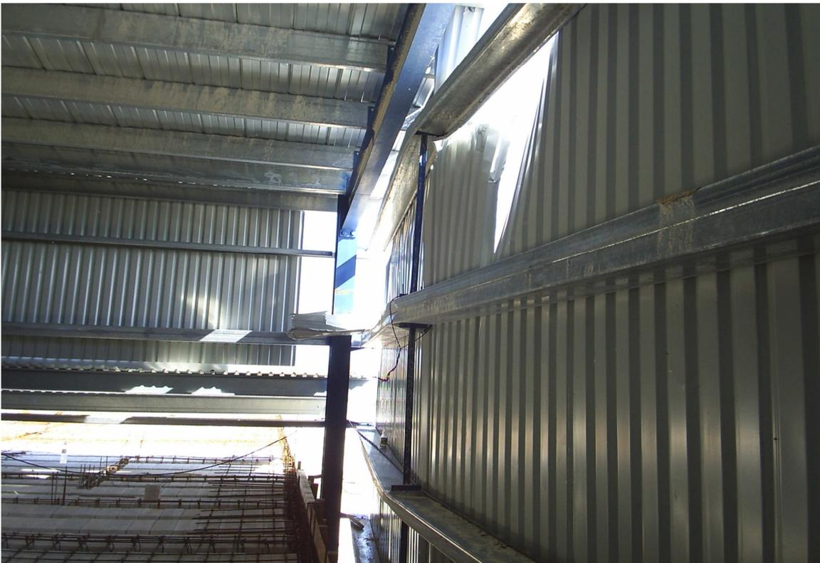
Figura No. 1.9 Deformación de largueros de muro.
