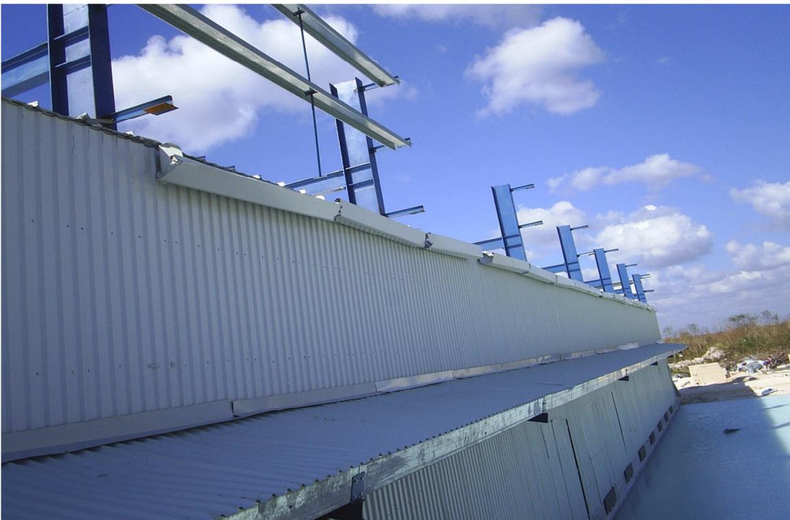
Figura No. 1.5 Desprendimiento de largueros, canalones y lámina.
