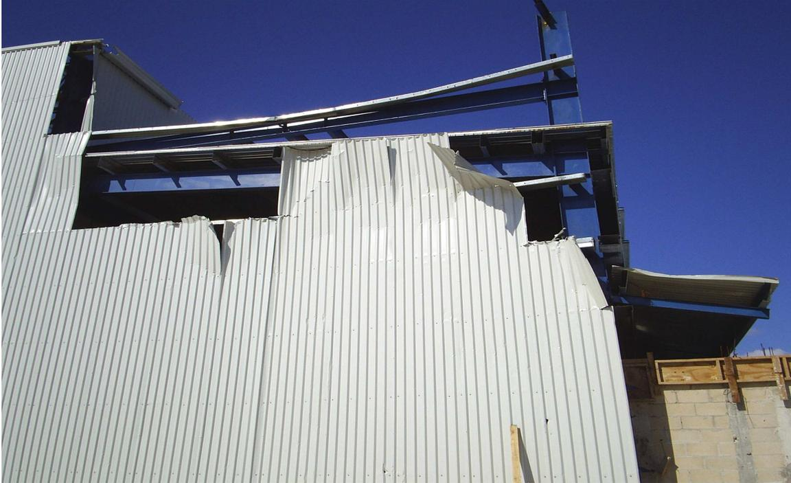
Figura No. 1.8 Desprendimiento de la lámina de los muros y daño en los largueros del muro.
