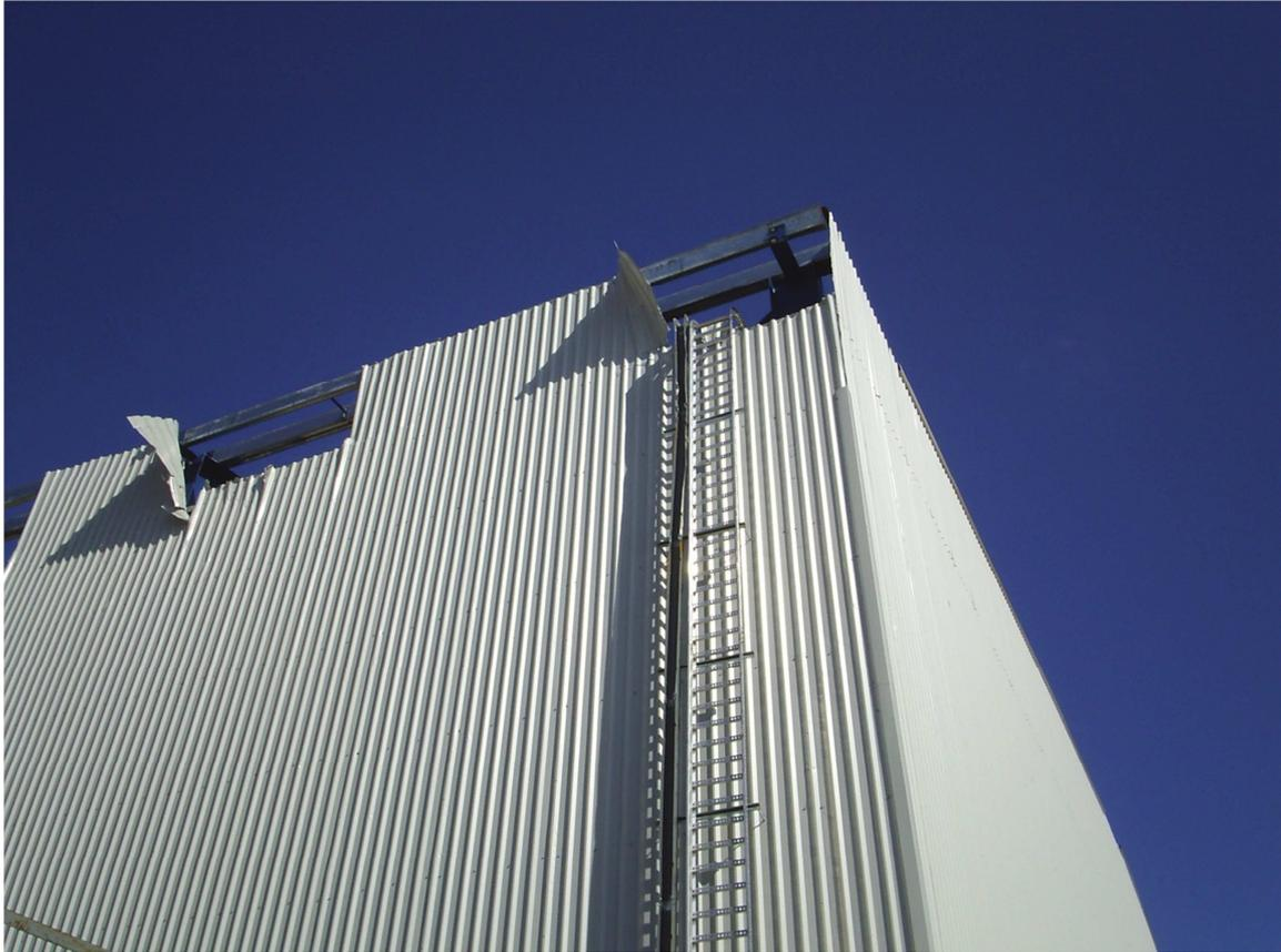
Figura No. 1.5 Desprendimiento de la lámina de los muros.
