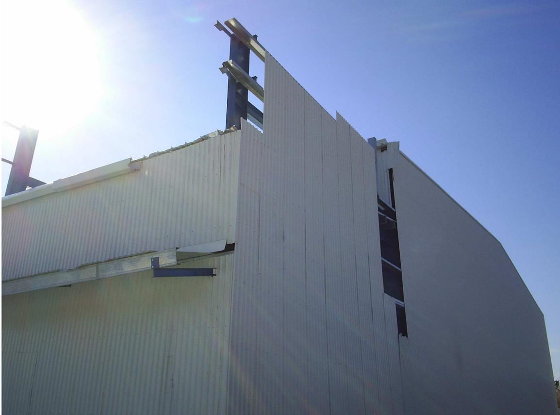
Figura No. 1.2 Desprendimiento de la lámina de los muros.
