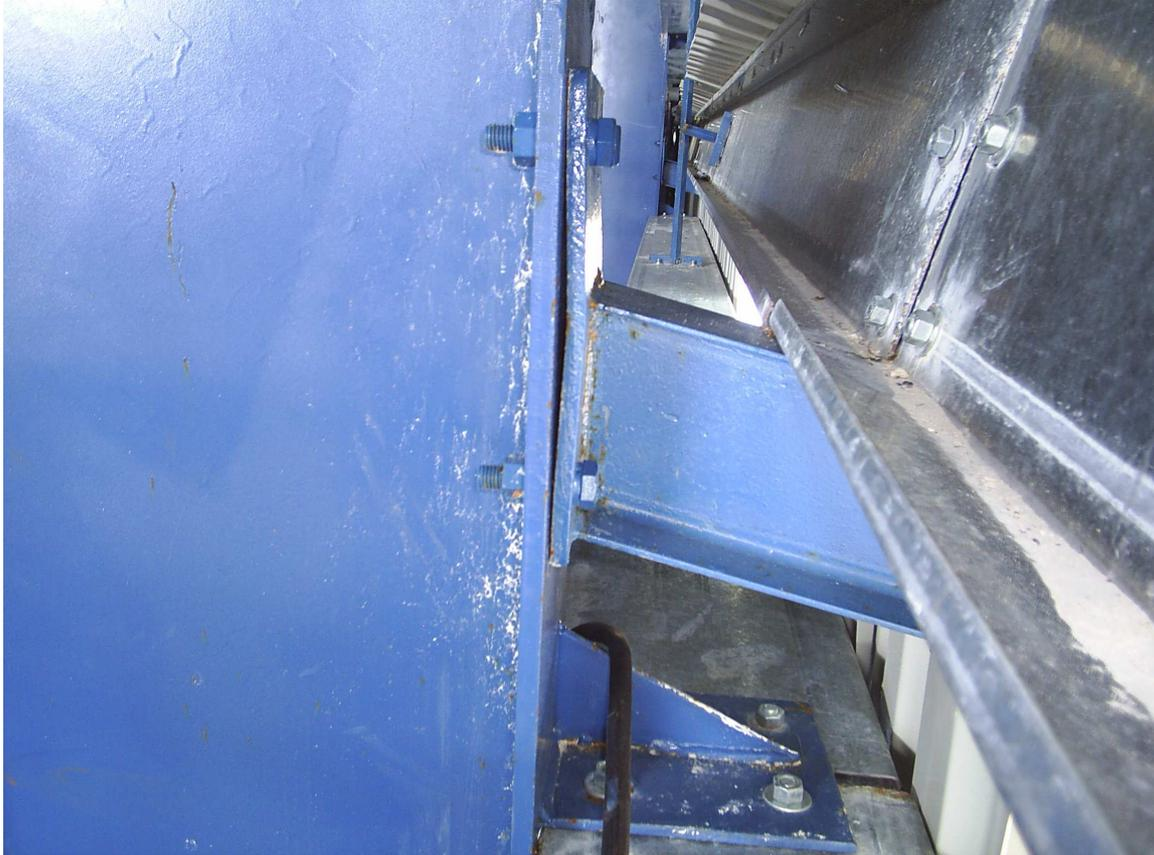
Figura No. 1.19 Conexión dañada de las vigas de la marquesina.
