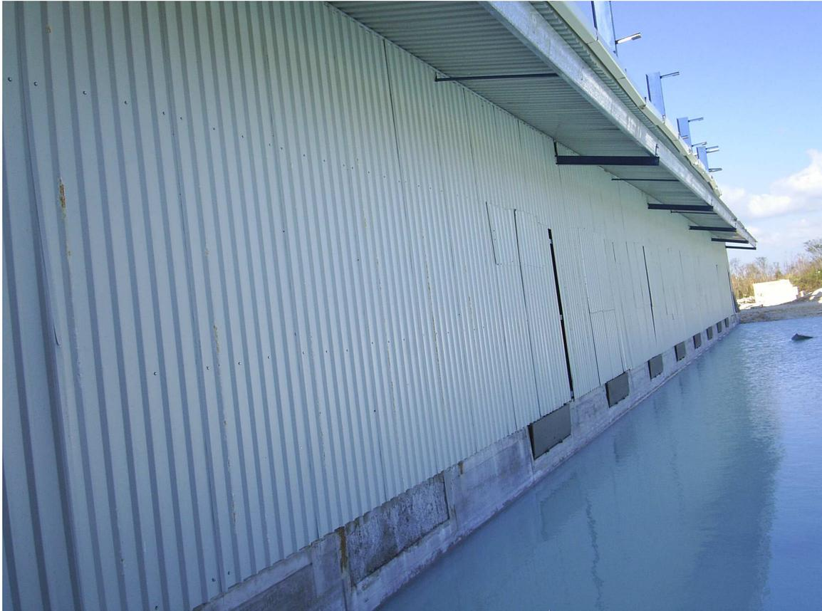
Figura No. 1.10 Deformación de la lámina de los muros y largueros de la marquesina.
